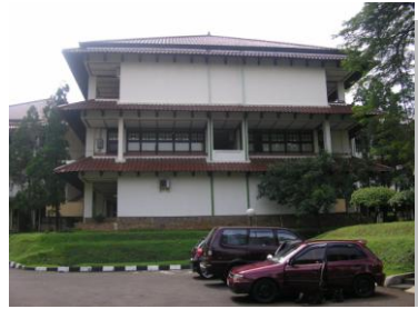
Gedung Perkuliahan & Lahan Parkir
